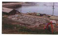
水産物加工場建設
