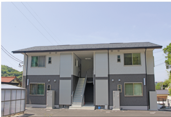
多沢定住促進住宅
