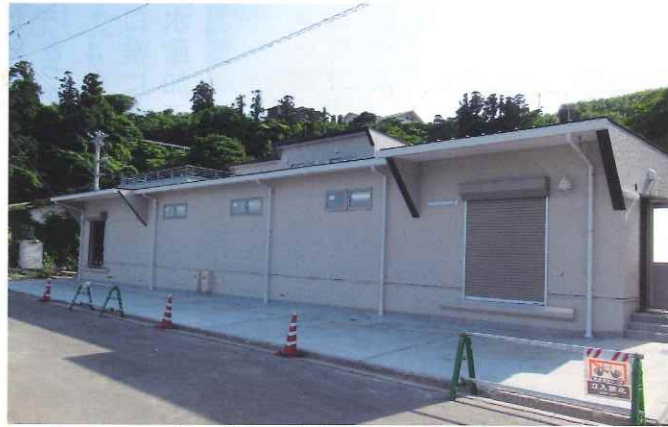
水産加工冷凍施設
