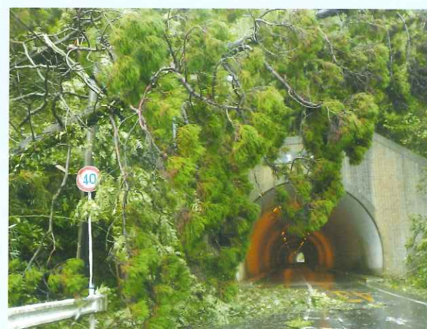
トンネルループ橋側
