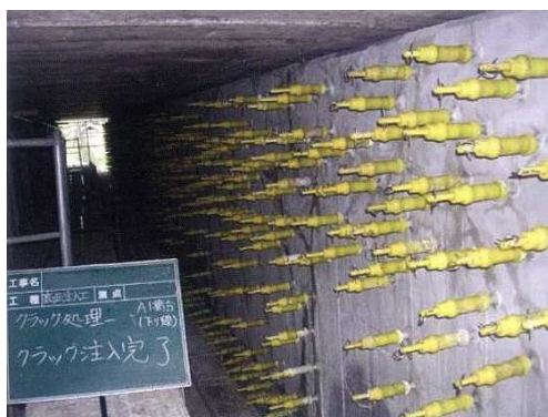
写真2 ひび割れ注入状況
