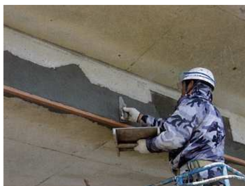
写真3 断面修復状況
