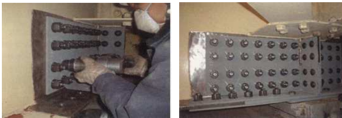
写真1 当て板工実施状況
