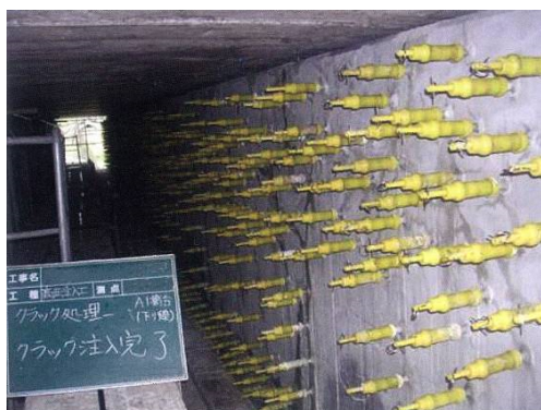
写真2 ひび割れ注入状況
