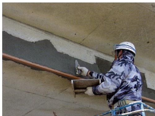
写真3 断面修復状況
