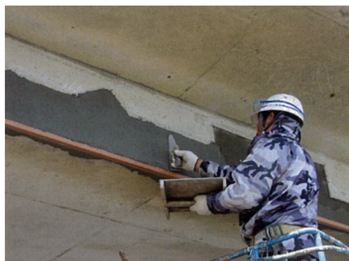
写真3 断面修復状況
