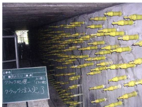
写真2 ひび割れ注入状況
